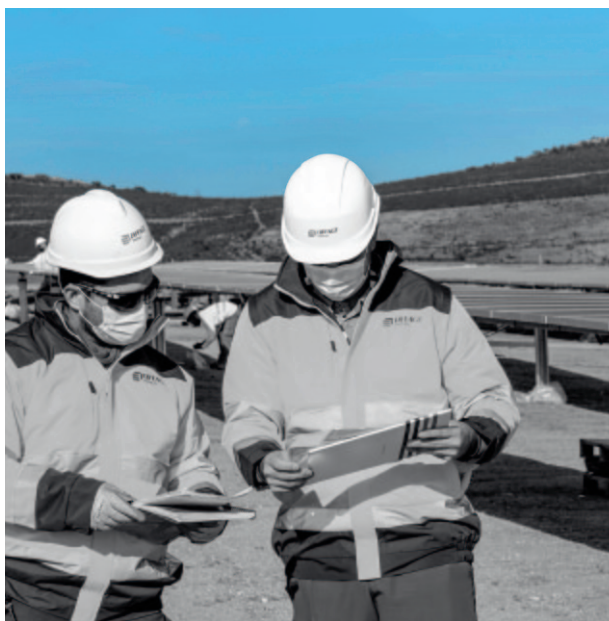
Centrale photovoltaïque Ceclavín, province de Cáceres, Espagne © Eiffage Energía Sistemas
