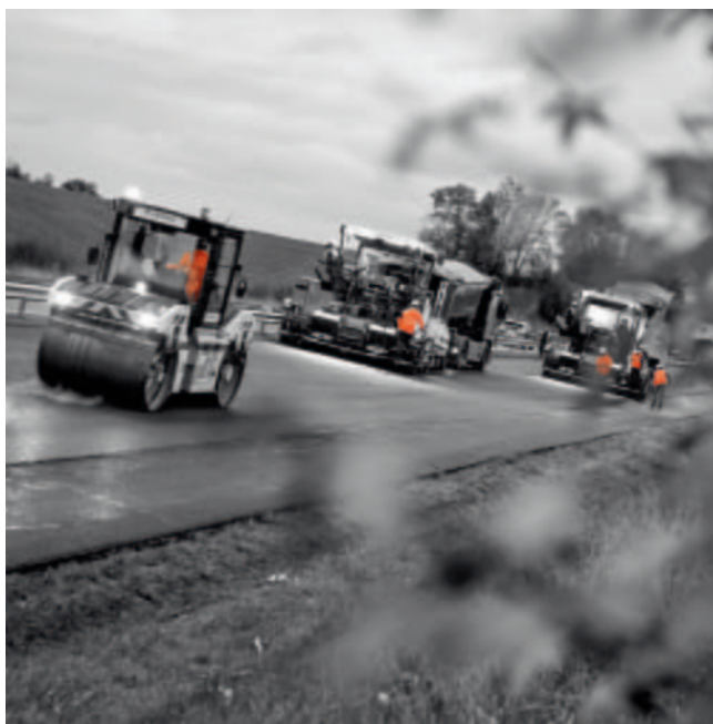
Einbau des pflanzlichen Asphalts Biophalt®, A40 Vonnas-Mâcon (Ain) © APRR
