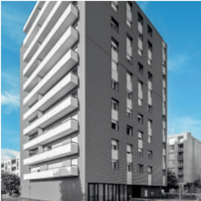
Energetische Sanierung der Residenz Thorez, Bègles (Gironde). © Eiffage/Alban Gilbert
