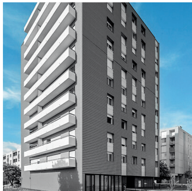
Rénovation énergétique de la résidence Thorez, Bègles (Gironde) © Eiffage/Alban Gilbert
