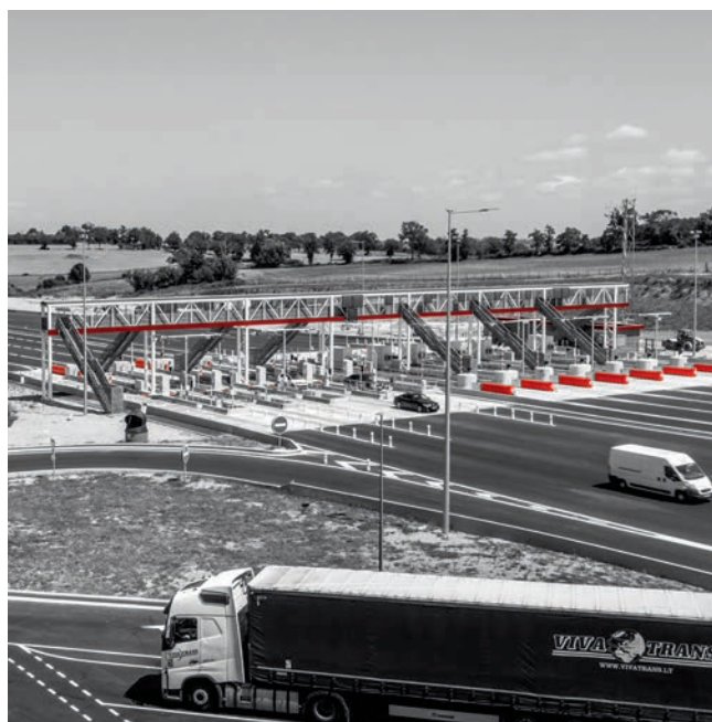
Gare de péage en flux libre sur l'A79, Digoïn (Saône-et-Loire) © Eiffage
