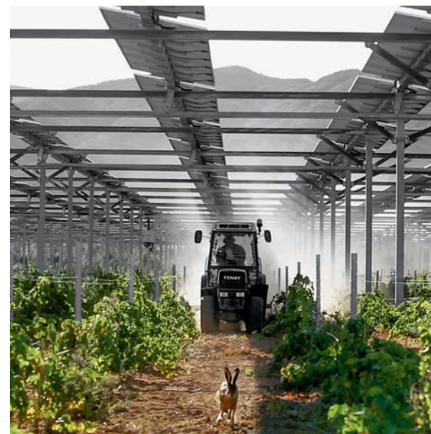
Panneaux photovoltaïques installés au-dessus des vignes, Tresserre (Pyrénées Orientales) © Sun'Agri
