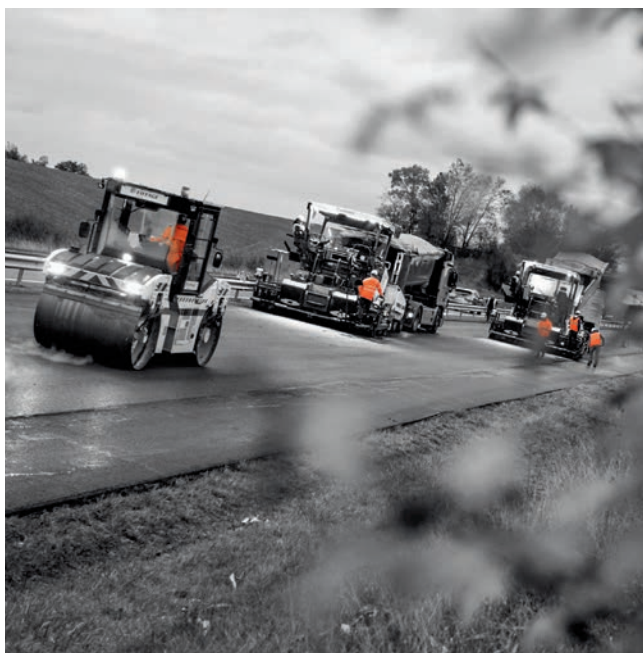
Pose de l'enrobé végétal Biophalt®, A40 Vonnas-Mâcon (Ain) © APRR
