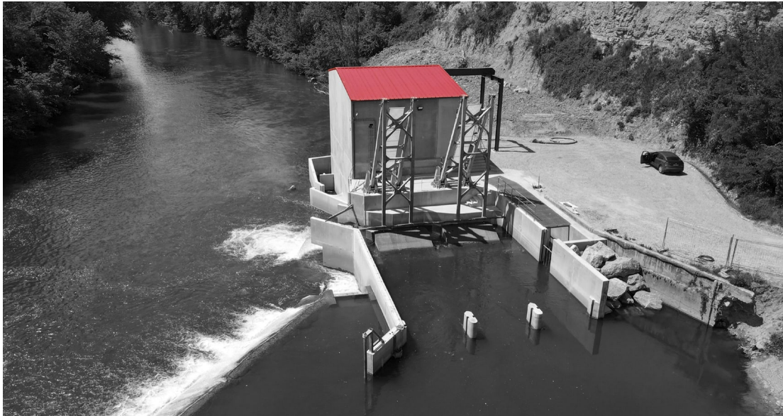
Wasserkraftwerk Caty (Tarn), das von Eiffage Énergie Systèmes umgebaut und saniert wurde und von Eiffage Concessions betrieben wird.
