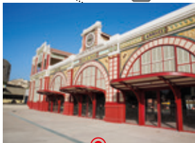
— TER Dakar (Sénégal) Conception-construction du TER de Dakar reliant le centre au futur aéroport international Blaise-Diagne (AIBD).
