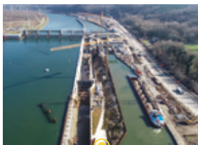
— Écluse Amsin (Belgique) Construction de 2 nouvelles écluses entre Liège et Namur.
