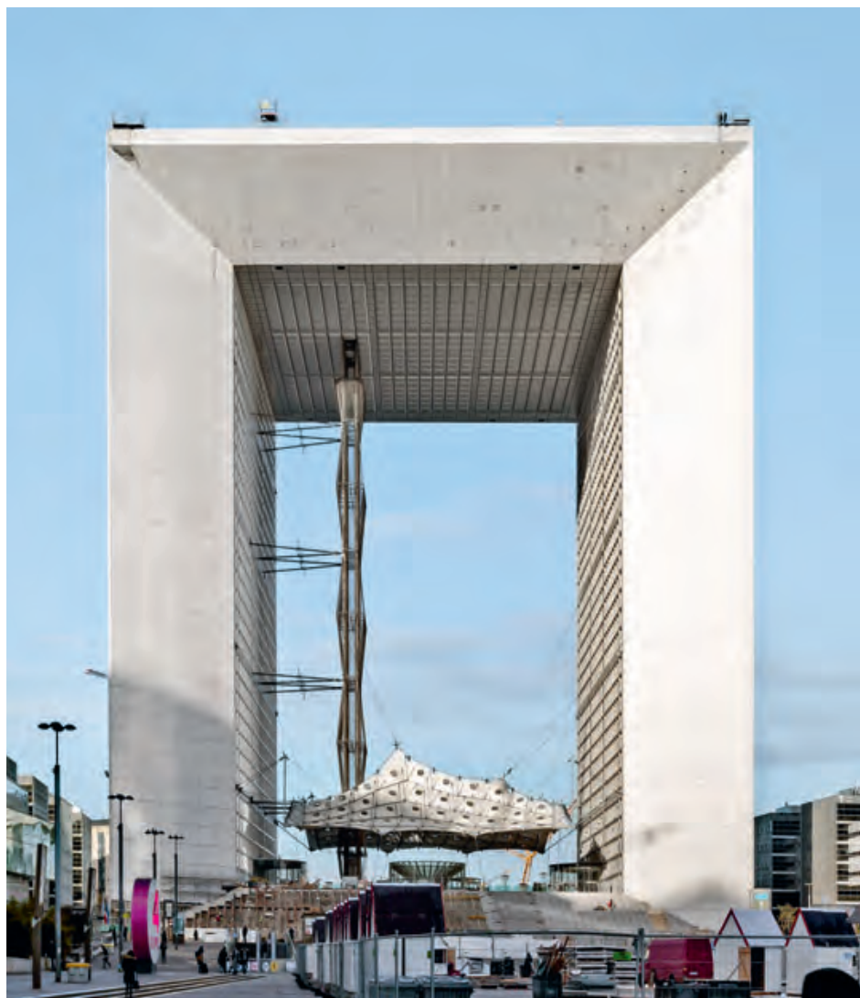
Renovation of the Grande Arche in La Défense
