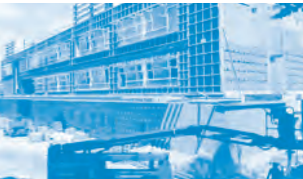
Construction du groupe scolaire Paul-Langevin à Fontenay-sous-Bois ©Eiffage
