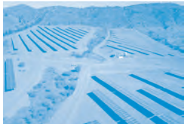
Centrale photovoltaïque de Marchihue VII ©Eiffage Energía Chile
