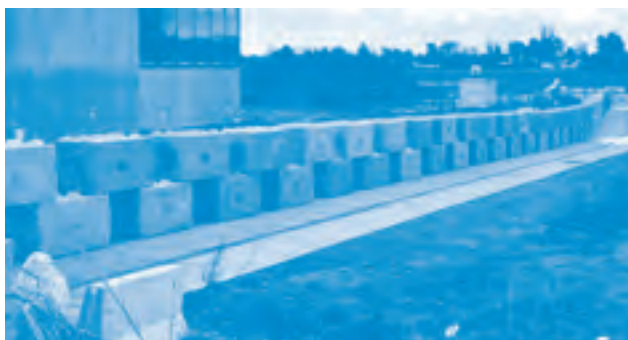
Blocs béton recyclés, les «smart bloc»
