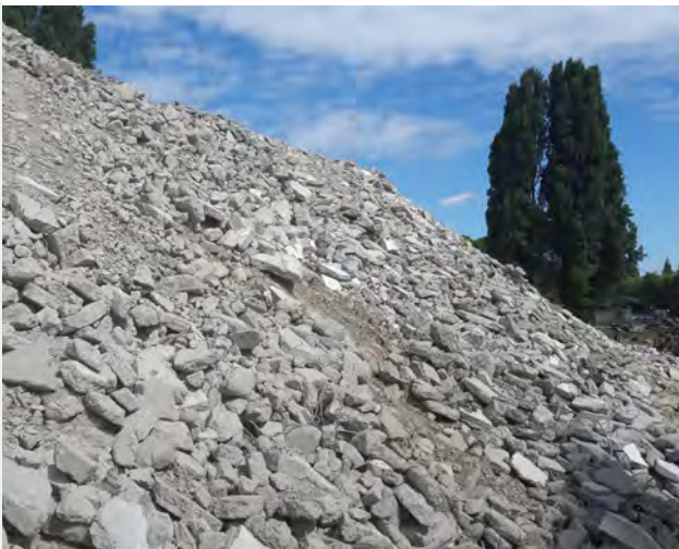
La déconstruction sélective nous permet de séparer et de trier sur place les différents éléments démolis afin de favoriser leur recyclage ou leur réemploi.
