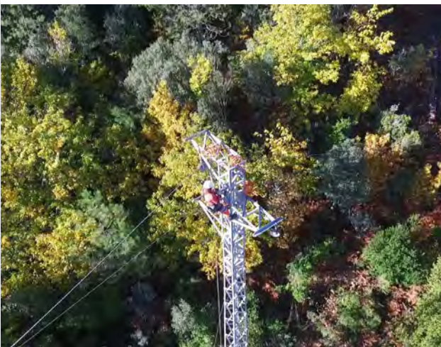
Espagne — Maintenance des lignes électriques d'Iberdrola
