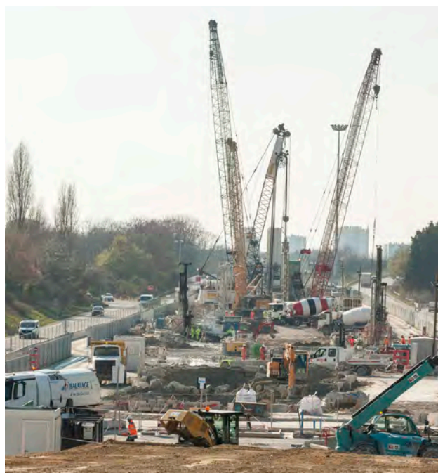
Région parisienne (France) — À travers les chantiers du Grand Paris, Eiffage Génie Civil participe à l'aménagement du futur réseau de transports en commun francilien.
