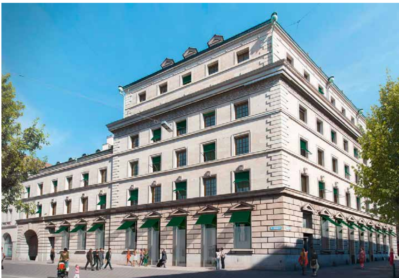
▲ Bahnhofstrasse 53 in Zürich erstrahlt in neuem Glanz
