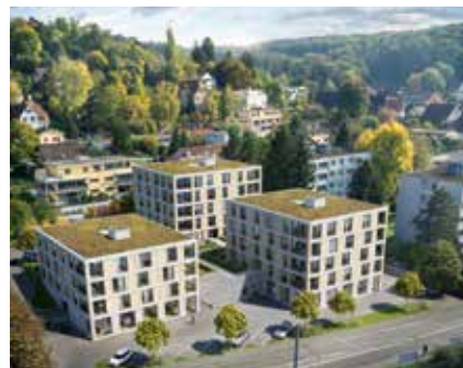
▲ Eigentumswohnungen «Kütschlihof», Bottmingen
