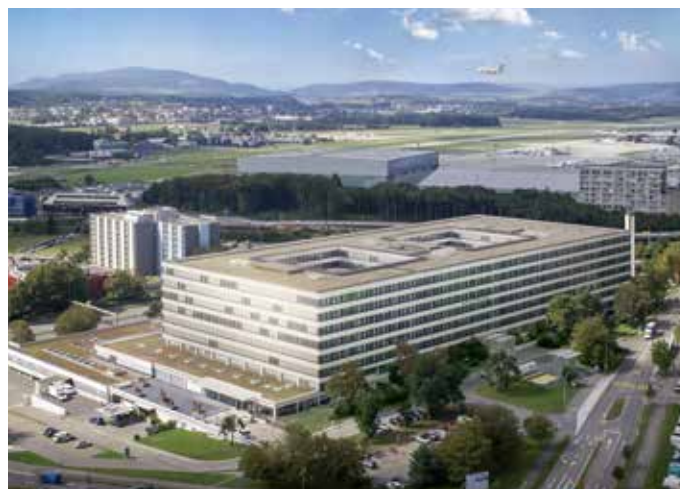
▲ Geschäftshaus «Balsberg» mit zehn Geschossen
