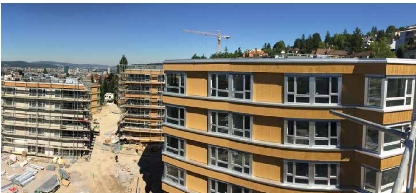
▲ Ersatzneubau Toblerstrasse, Zürich, 2. Etappe
