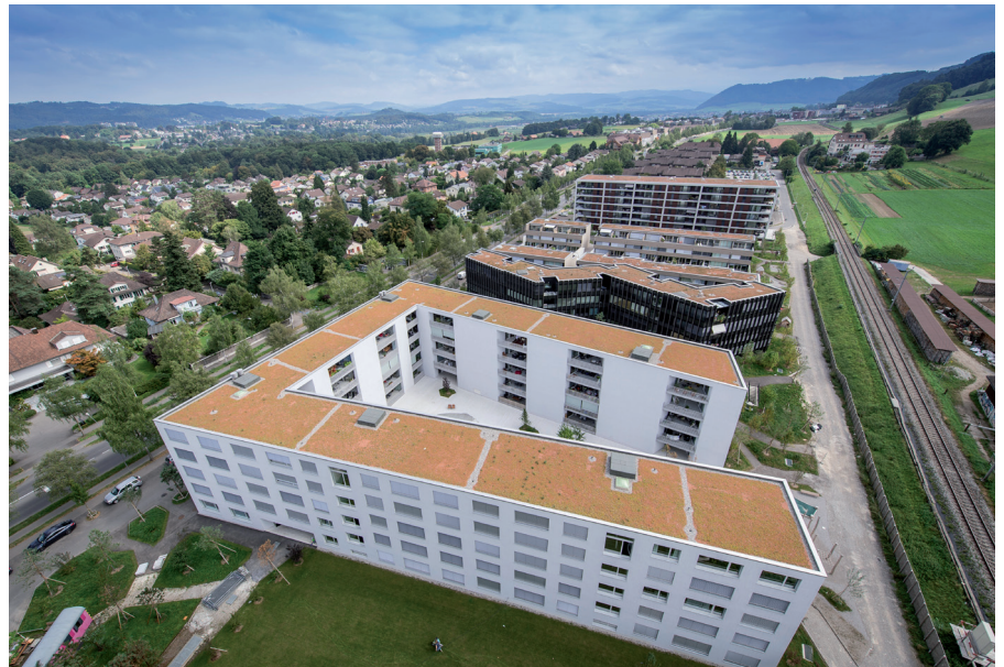
Wohnüberbauung «Bächtelenpark», Blick aus dem Hochhaus
